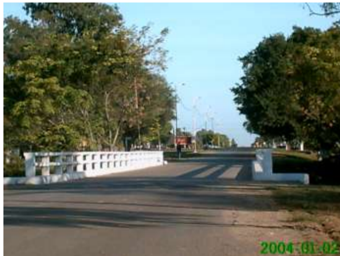
PUENTE SOBRE EL RIO SALADO
