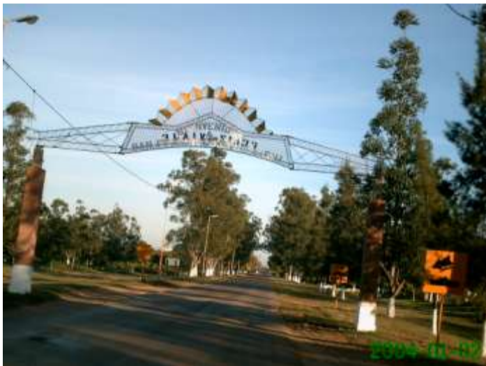
ARCO DE LA ENTRADA
